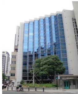
サムティ本町グランドビル (大阪市西区)
